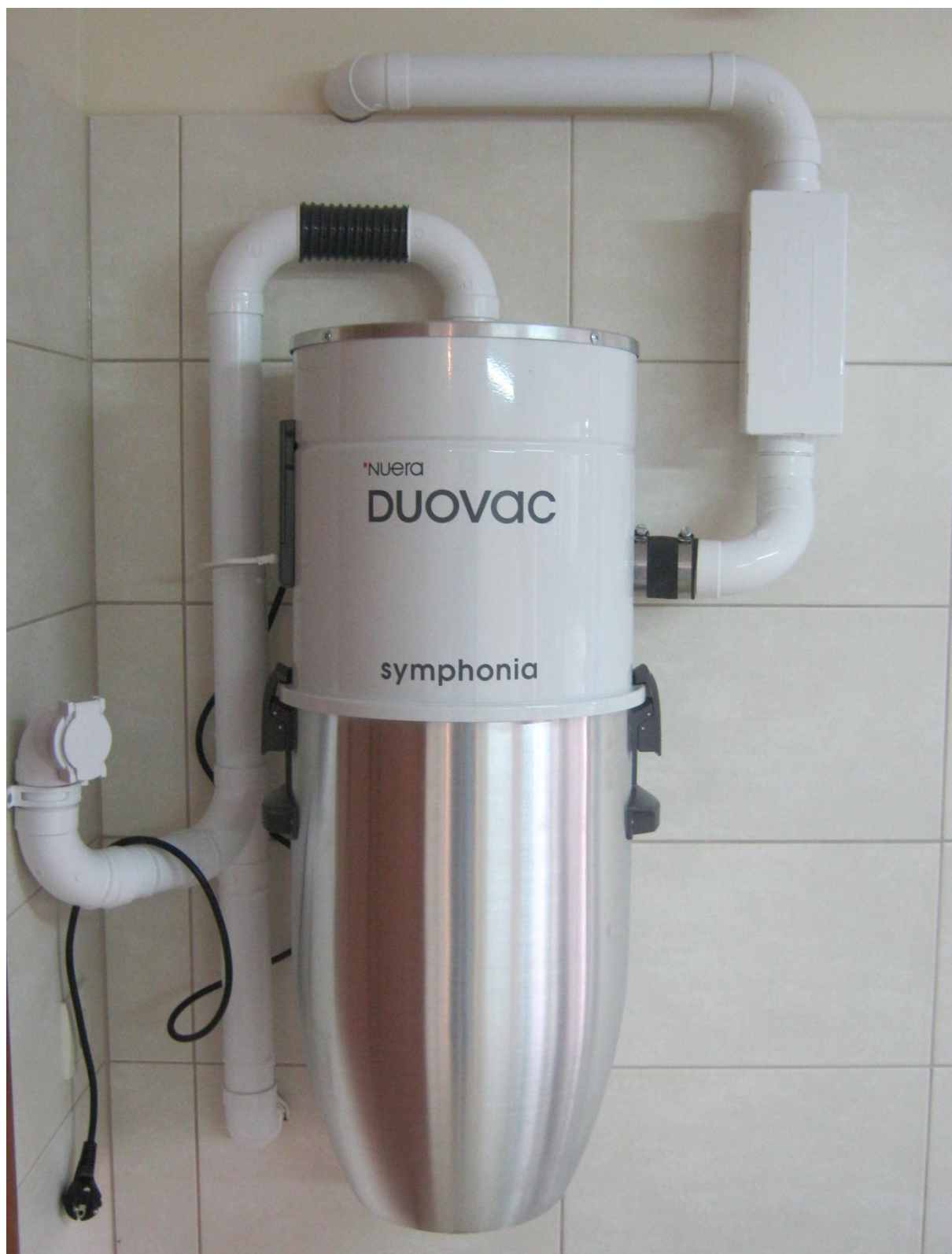
Rys. 8. Jednostka centralna z zamontowanym gniazdem natynkowym
