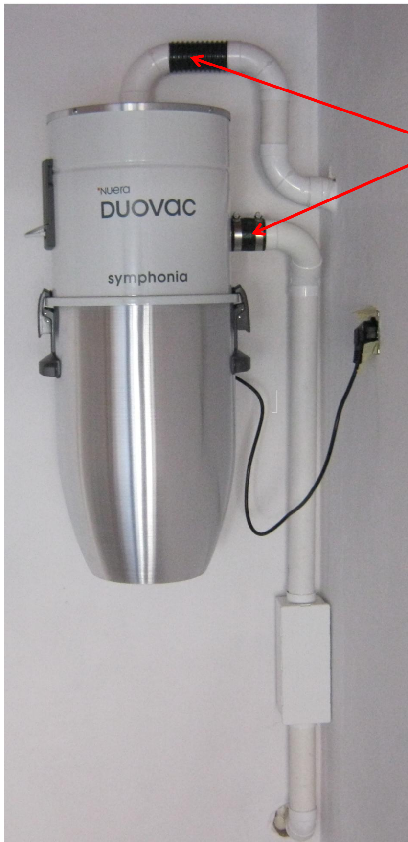
Rys. 5. Jednostka centralna z tłumikiem zamontowanym w dół
